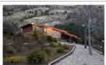
RRG_E_MA_A64_01 contenido: vista exterior autoría de la imagen: Luis Argüelles /Fundación DOCOMOMO Ibérico fecha de realización: 03/2011
