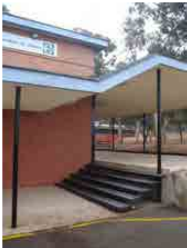
RRG_E_VA_A36_03 contenido: vista exterior autoría de la imagen: Carlos Izquierdo García y Víctor Muñoz Macián/Fundación DOCOMOMO Ibérico fecha de realización: 25 de febrero de 2009
