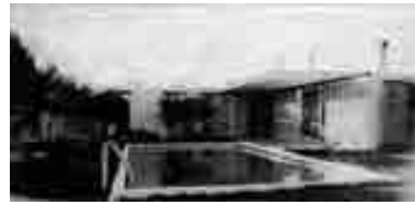
RRG_V_CAT_A28_5 contenido: vista exterior autoría de la imagen: AH COAC Cuadernos de Arquitectura 33, 1958/Fundación DOCOMOMO Ibérico fecha de realización:
