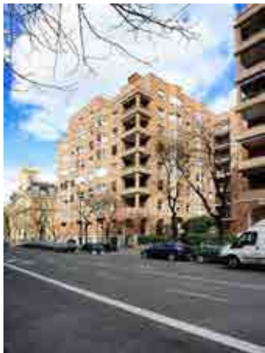
RRG_V_MA_A10_2 contenido: vista exterior autoría de la imagen: José Hevia /Fundación DOCOMOMO Ibérico fecha de realización: 10/2008
