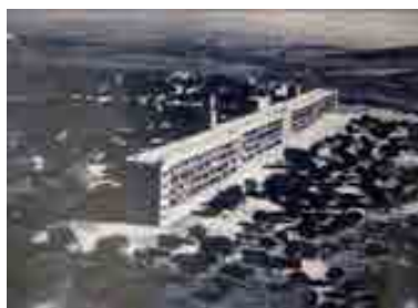
RRG_E_CASTLEON_A07_52 contenido: vista exterior autoría de la imagen: AAVV. Sanatorio de los Montalvos: guía para una visita. Salamanca 2008/Fundación DOCOMOMO Ibérico
