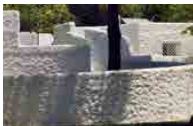
RRG_E_AND_OR_A26_36 contenido: vista exterior autoría de la imagen: Instituto Andaluz del Patrimonio Histórico/Fundación DOCOMOMO Ibérico fecha de realización: 2009
