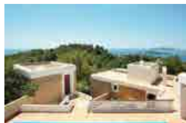
RRG_V_ISLAS_BA_A19_9 contenido: vista exterior casa José Luis Sert autoría de la imagen: José Hevia /Fundación DOCOMOMO Ibérico fecha de realización: 09/2008
