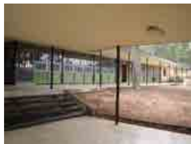
RRG_E_VA_A36_06 contenido: vista exterior autoría de la imagen: Carlos Izquierdo García y Víctor Muñoz Macián/Fundación DOCOMOMO Ibérico fecha de realización: 25 de febrero de 2009
