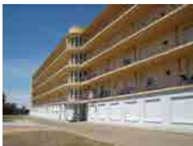
RRG_E_CASTLEON_A07_04 contenido: vista exterior autoría de la imagen: Alejandro Martín Herrero /Fundación DOCOMOMO Ibérico fecha de realización: 2009
