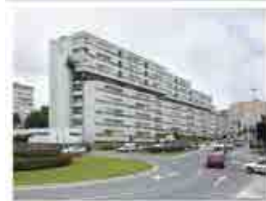
RRG_V_GA_A28_8 contenido: vista exterior autoría de la imagen: Luis Argüelles /Fundación DOCOMOMO Ibérico fecha de realización: 2009
