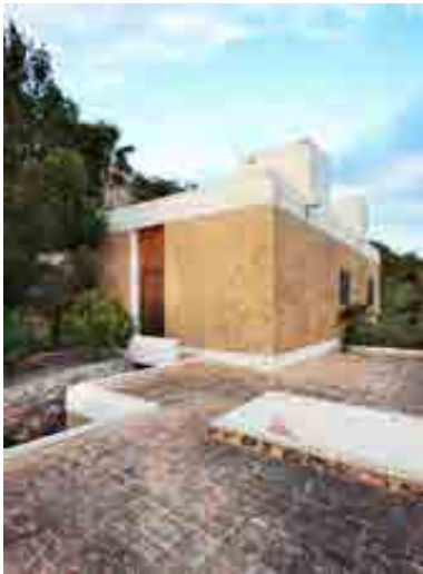
RRG_V_ISLAS_BA_A19_13 contenido: vista exterior casa Zao-Wo-Ki autoría de la imagen: José Hevia /Fundación DOCOMOMO Ibérico fecha de realización: 09/2008
