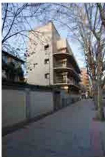
RRG_E_MA_A01_1 contenido: vista exterior autoría de la imagen: Luis Argüelles/Fundación DOCOMOMO Ibérico fecha de realización: 04/2010
