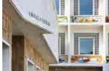
RRG_E_AND_OCC_A04_06 contenido: vista exterior autoría de la imagen: José Hevia/Fundación DOCOMOMO Ibérico fecha de realización: abril de 2011
