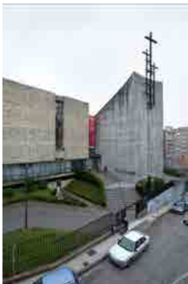
RRG_E_CANT_A09_05 contenido: vista exterior autoría de la imagen: Luis Argüelles/Fundación DOCOMOMO Ibérico fecha de realización: 05/2010
