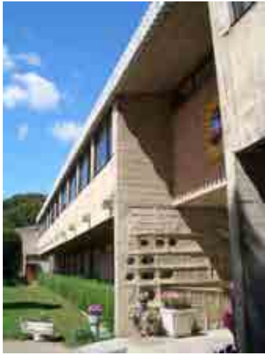
RRG_E_CASTLEON_ESTE_A26_01 contenido: vista exterior autoría de la imagen: Daniel Villalobos Alonso/Fundación DOCOMOMO Ibérico fecha de realización: 2009
