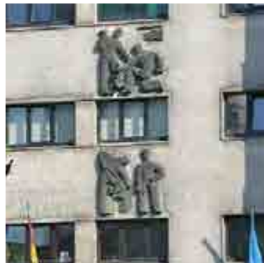
RRG_V_AST_A01_13 contenido: vista exterior, detalle bajo relieve autoría de la imagen: Luis Argüelles/Fundación DOCOMOMO Ibérico fecha de realización: marzo de 2008
