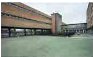
RRG_E_CANT_A09_07 contenido: vista exterior autoría de la imagen: Luis Argüelles/Fundación DOCOMOMO Ibérico fecha de realización: 05/2010
